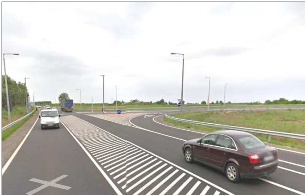
354. számú főút és a jobboldalon csatlakozó 4. számú főút csomópontja
